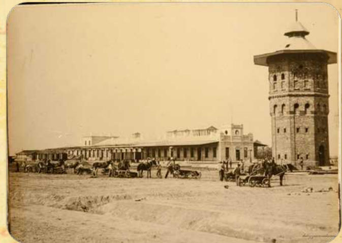
Budowa kolei warszawsko kaliskiej
